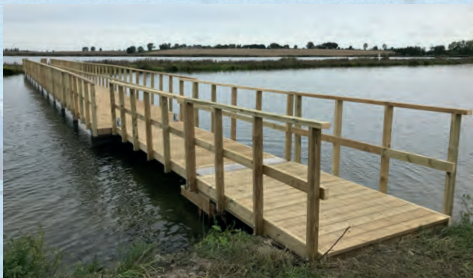
Sybergland, Kerteminde 39 meter træbeton, SF 31, 2,4 m.
